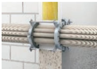
Dubbelsidig montering av rörmanschetterna vid vägginstallation
