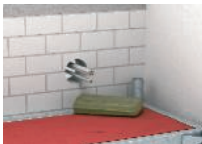
Mineralull med smältpunkt \geq 1000 °C för att täppa igen öppningen
