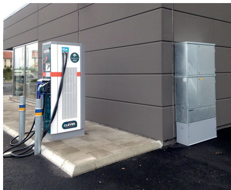
Utomhuscentral som matar en ABB laddstolpe.
