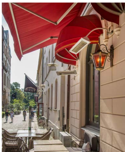
Med en rörkonsol, kan värmaren placeras lägre än sin infästningspunkt.
