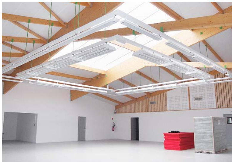
Byggnader som används oregelbundet kan värmas upp snabbt utan hög energiförbrukning. EZ100 smälter väl in bland belysningsarmaturer.
